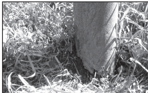
In basso: Un palo elettrico divorato dalla ruggine pronto a cadere
