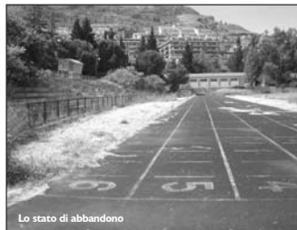
Lo stato di abbandono
