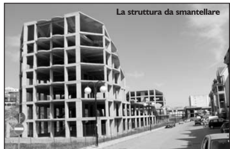
La struttura da smantellare
