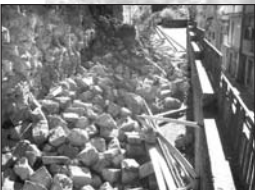
Muro - Villa Torre di Federico
