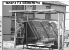
Pensilina Via Risorgimento
