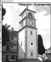
Villapriolo - il campanile
