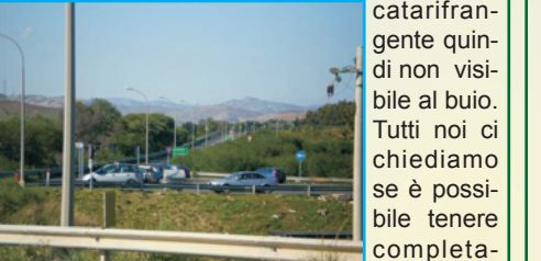
A19 svincolo Catenanuova
