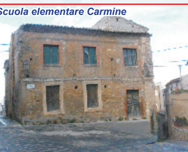
Scuola elementare Carmine
