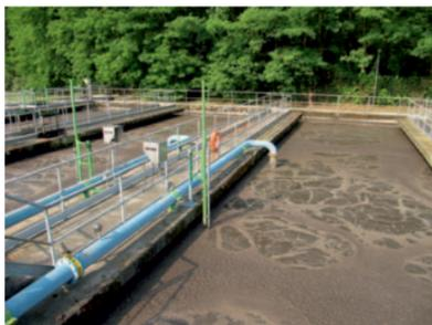
I trattamenti ai quali i fanghi devono essere sottoposti, sono finalizzati all'ottenimento di un volume di fango più esiguo e quindi più gestibile. Il fango liquido (concentrazione in solidi 1 - 5 %) viene disidratato sino ad ottenere un contenuto in solidi variabile dal 18 al 40%.
